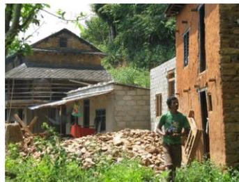
鉄筋や柱は入れておらず、地震で壊れた家と同じ構造で、耐震工法を取り入れないまま再建しようとしている。
